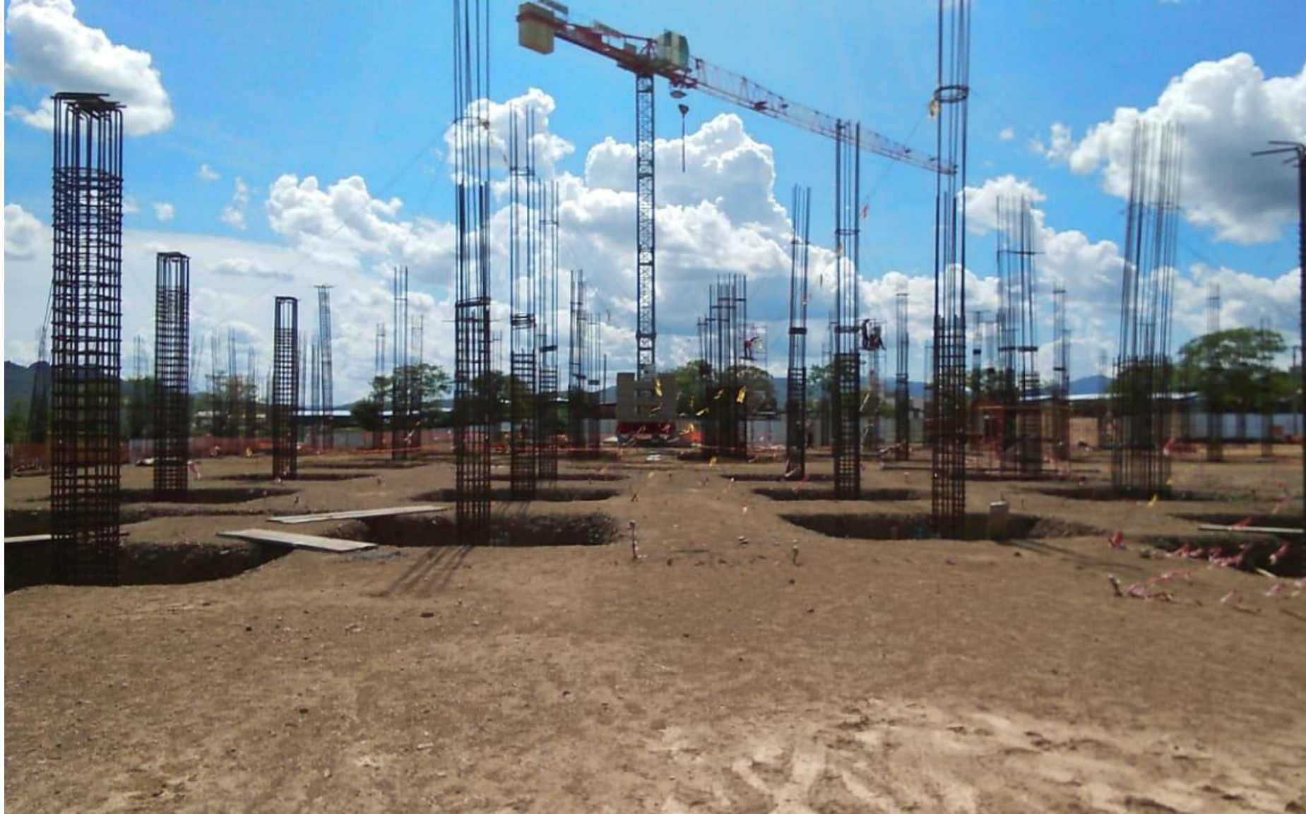
Avances Edificio A y D.
