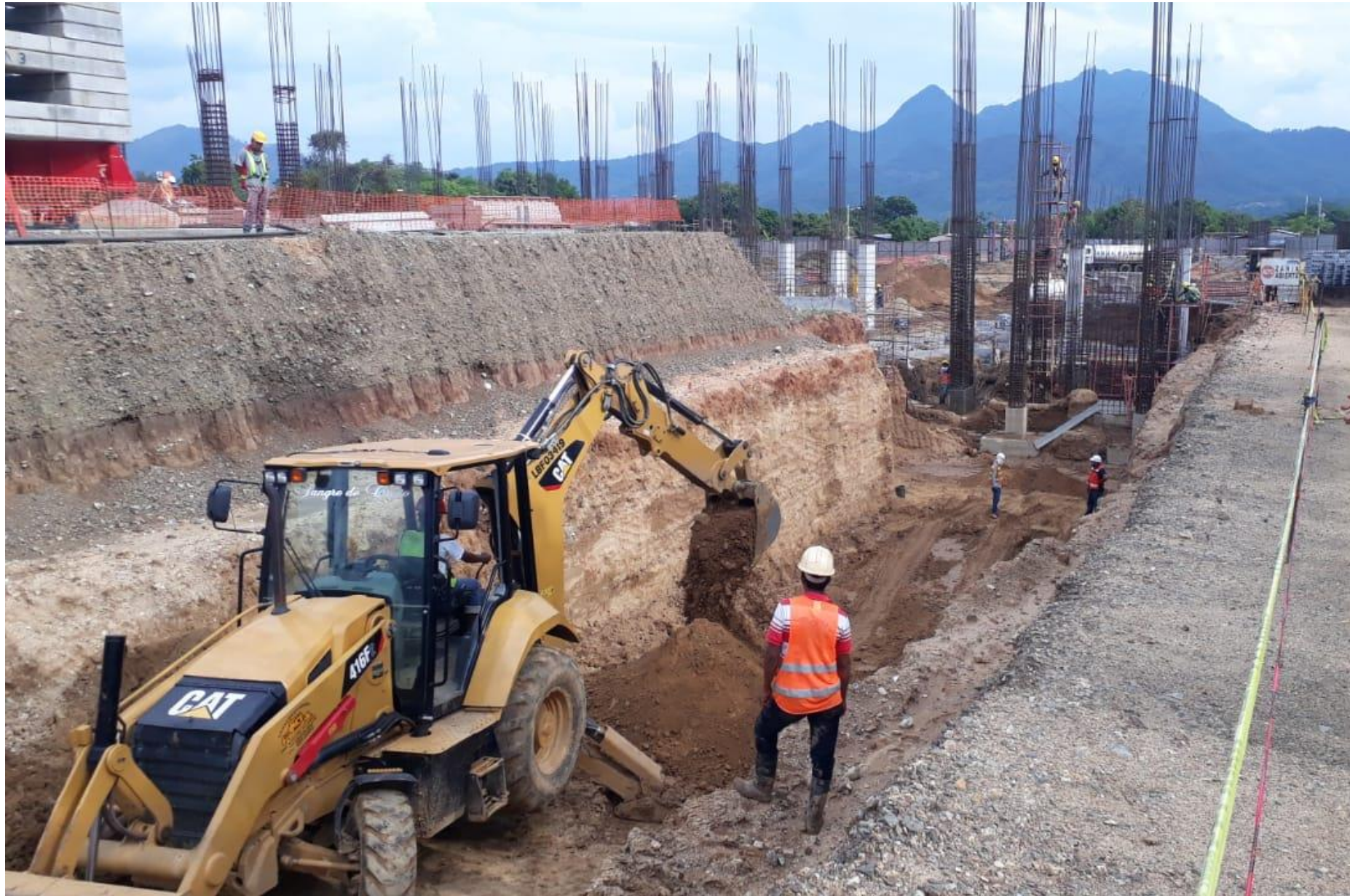
Excavaciones en rampa.
