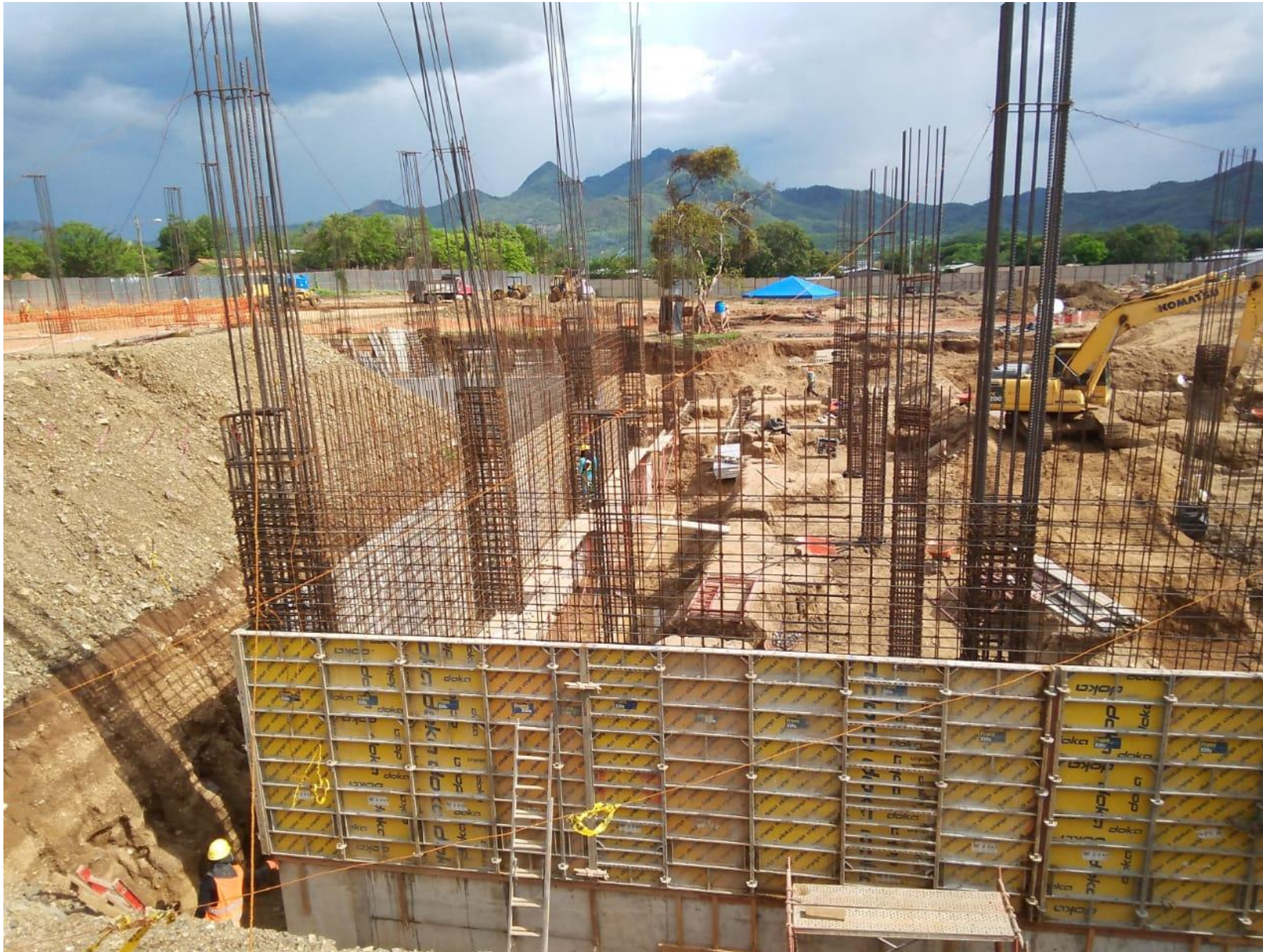
Muro de contención
