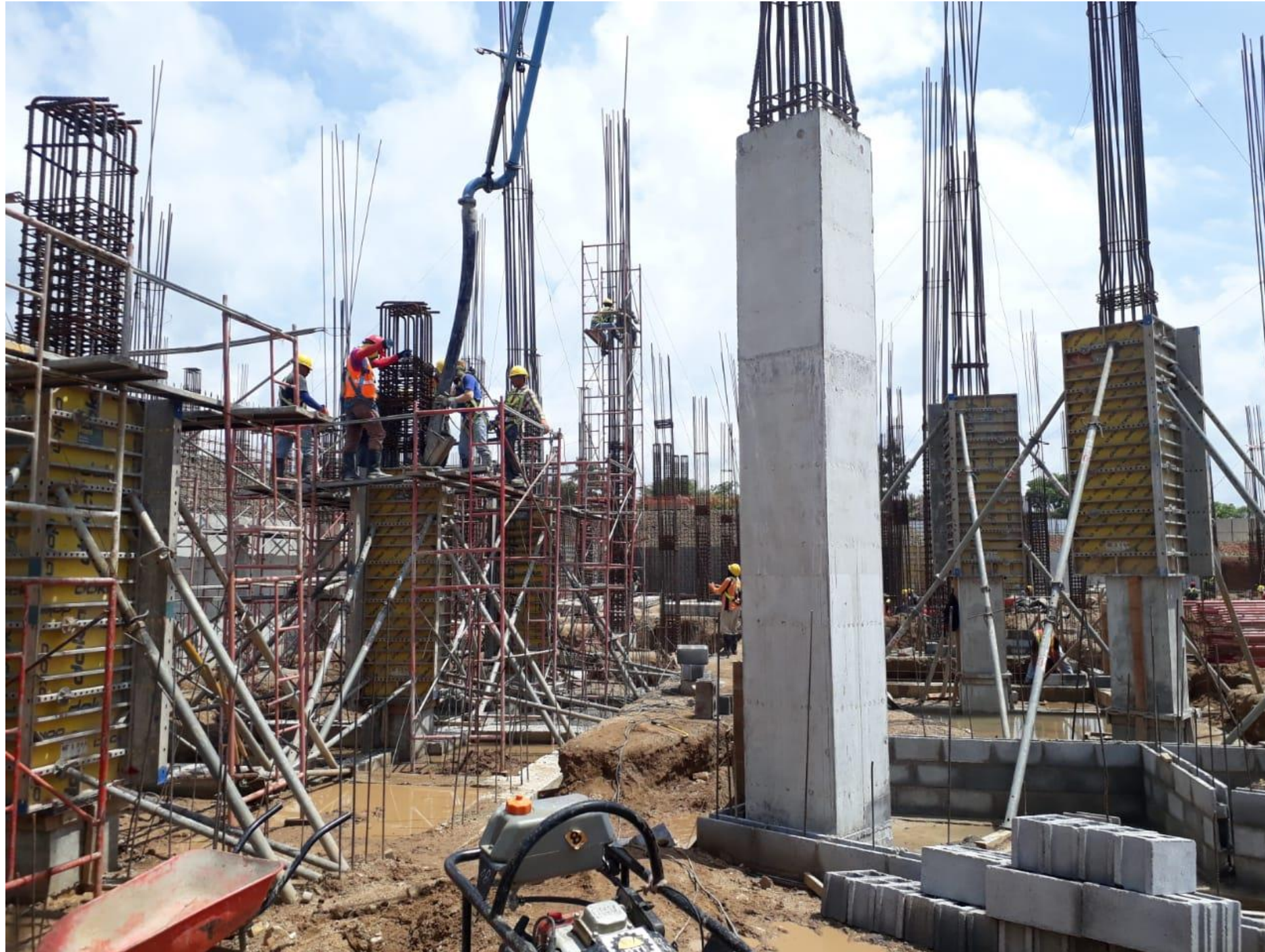
Avances en columnas Edificio A.
