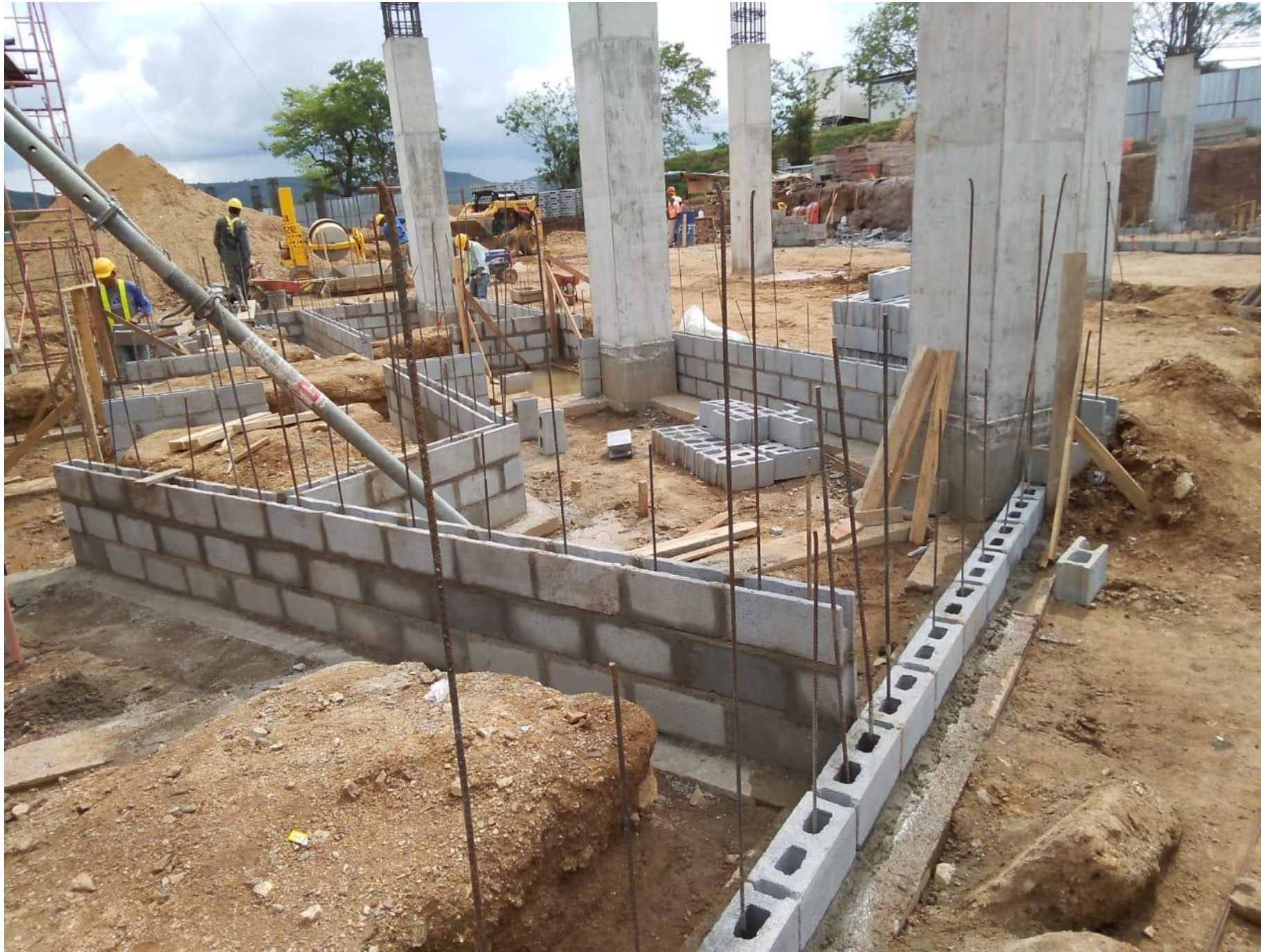
Colocación de mampostería reforzada.
