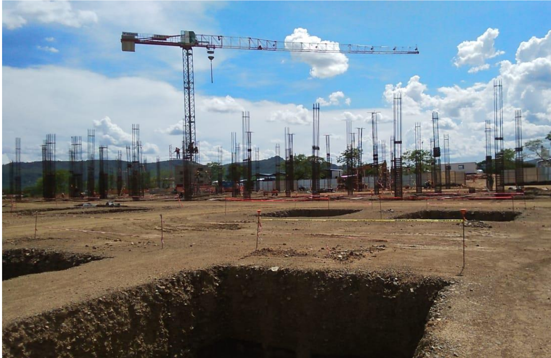
Avances Edificio A, B y E.
