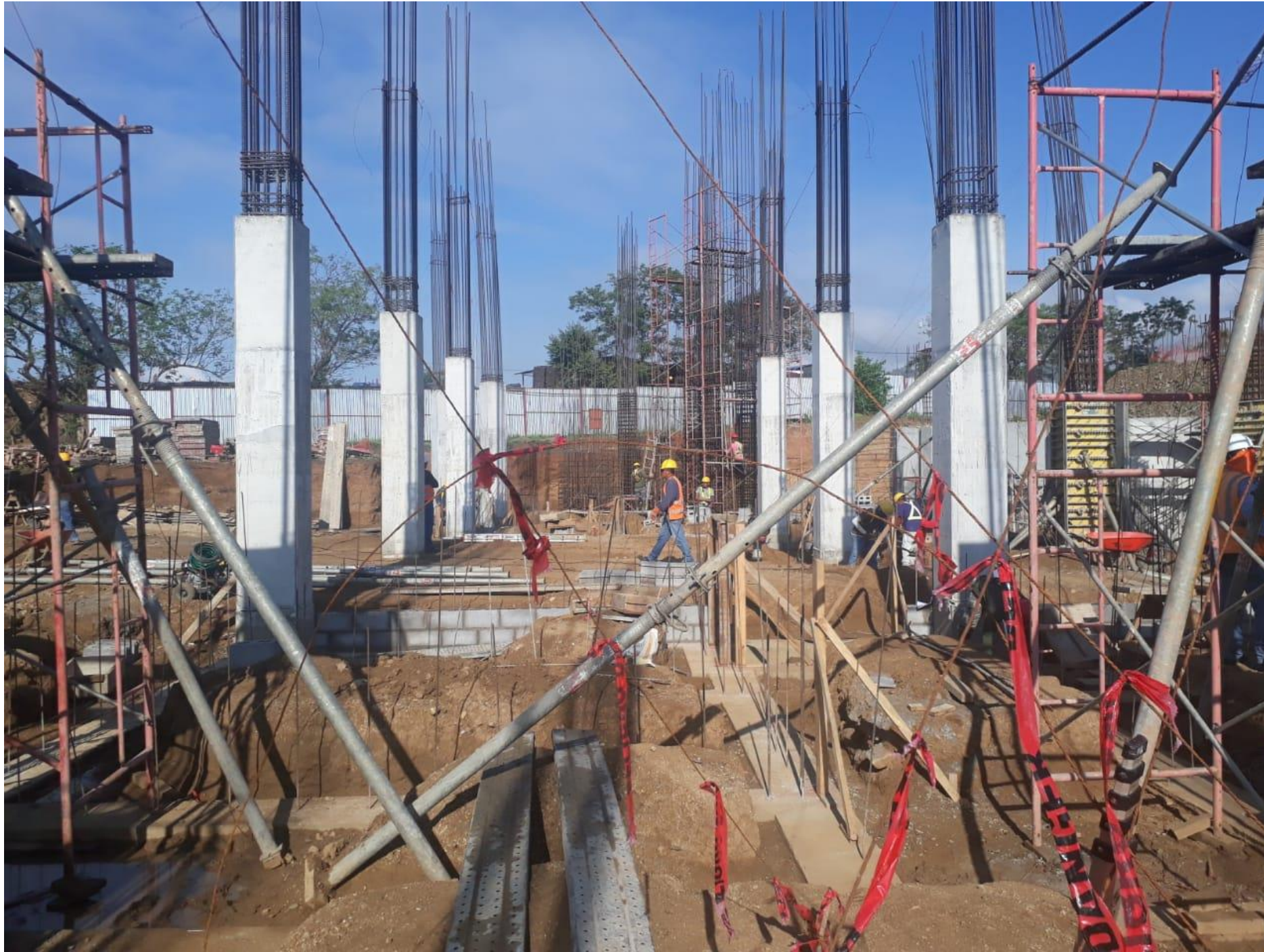
Avances Edificio A.
