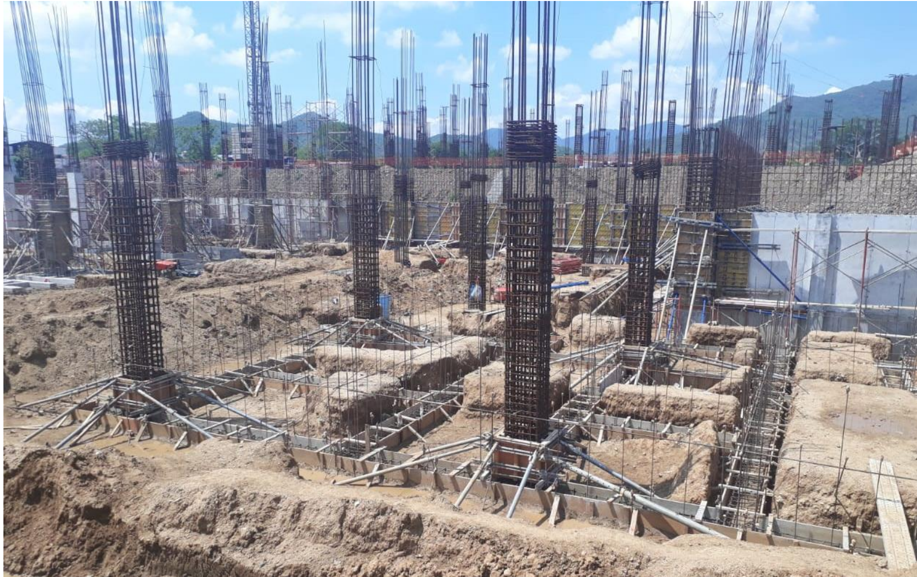
Vista avances generales Edificio A y D.
