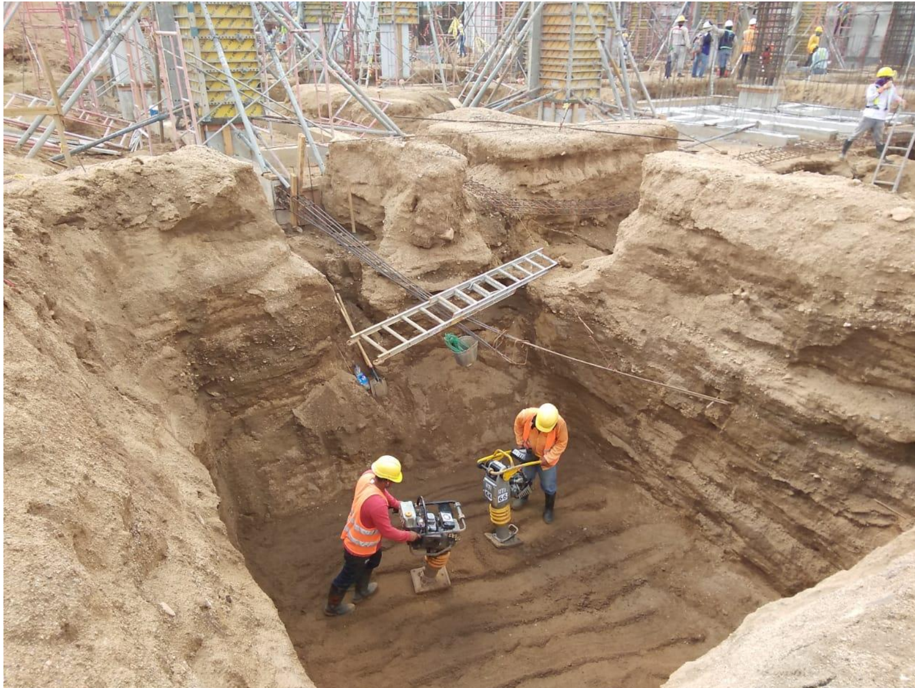
Compactación de suelo natural.
