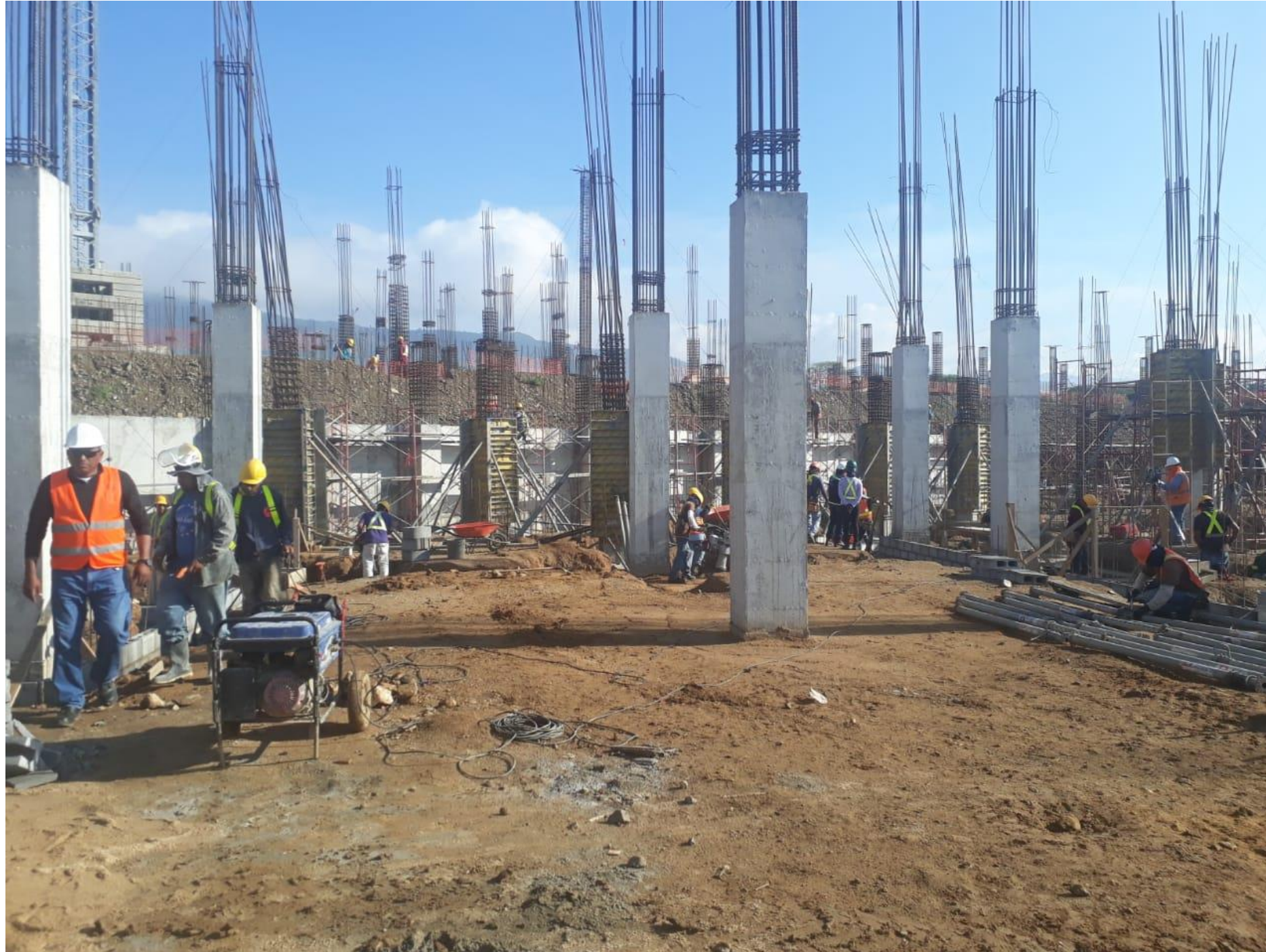
Relleno y mejoramiento en Edificio A
